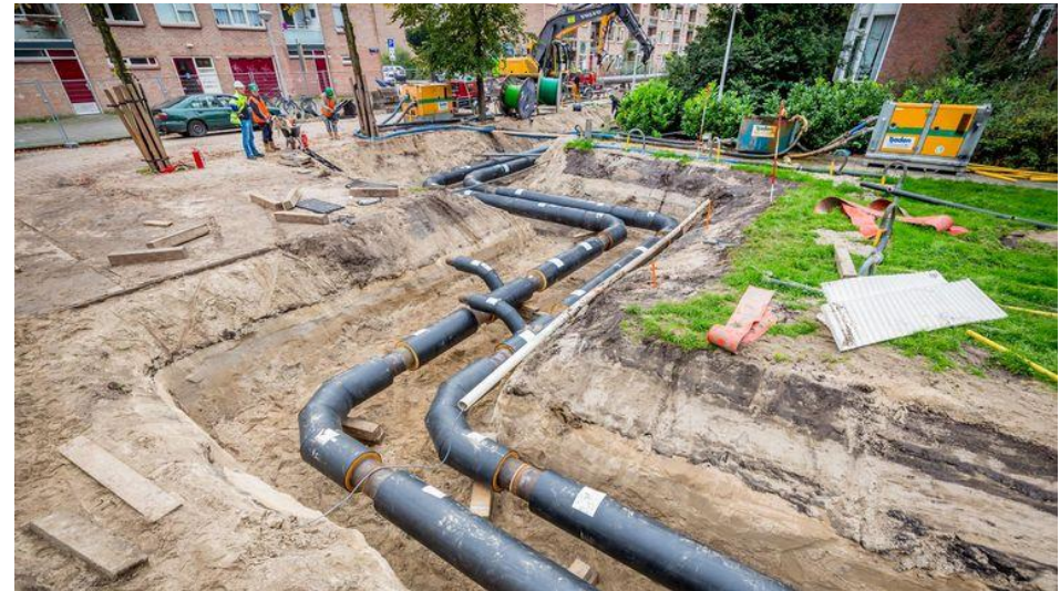
Voorbeeld aanleg warmtenet
