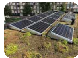
Groen dak met pv-panelen
