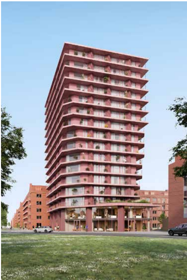
Indruk van nieuwe woontoren aan de rotonde in de hoek van de Burgemeester Röellstraat en Sloterveerlaan
