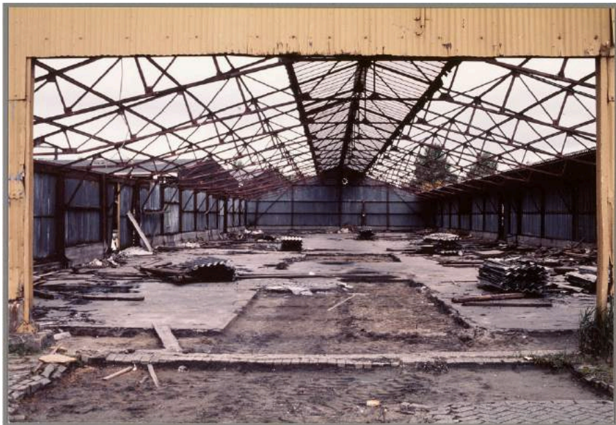
Sloop van de houtloodsen met stalen spanten, 1992
