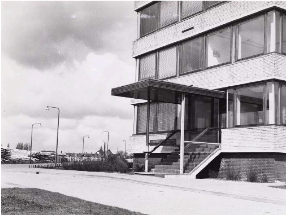
Zuidgevel met hoofdingang met oorspronkelijke luifel, 1969, vierkante ramen in horizontale lichtstroken afgewisseld met licht gekleurd metselwerk. Links de W. Pontbrug en houtopslag.
