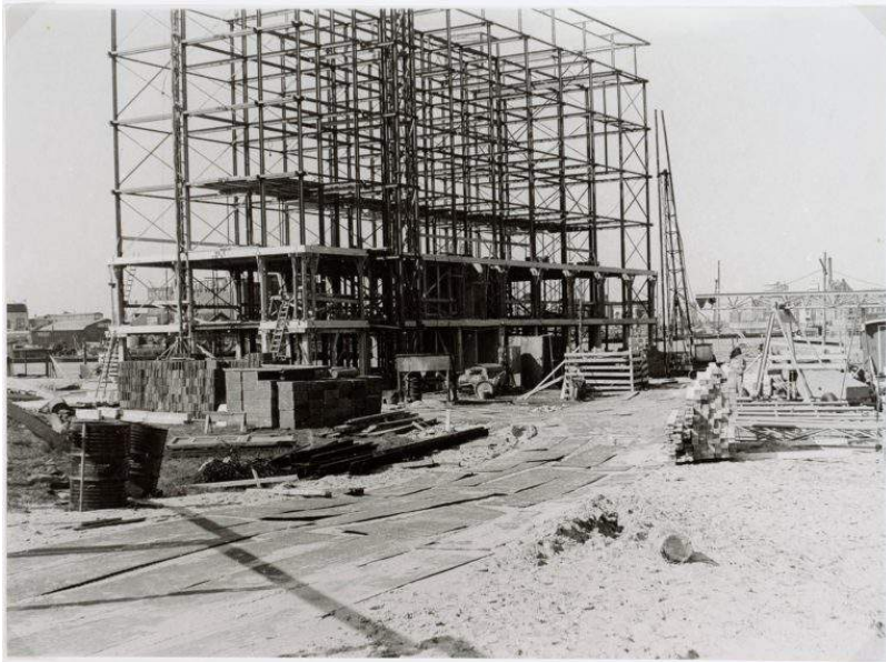
Bouw van staalskelet, 1963
