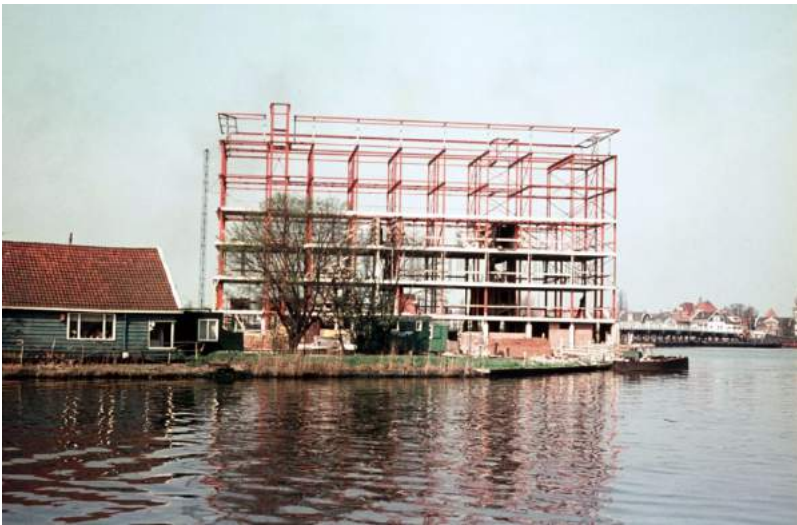
Staalskelet met betonnen vloeren, W Pontbrug op de achtergrond
