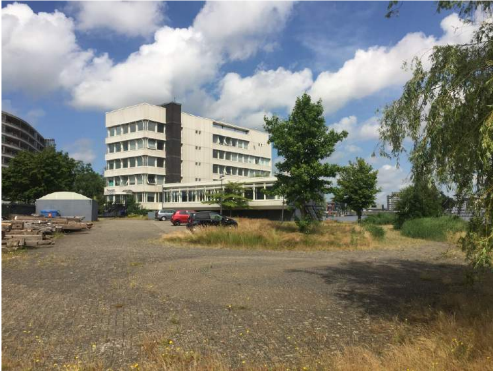
Zuidgevel met ingang, oostgevel met liftschacht en kantoorvleugel
