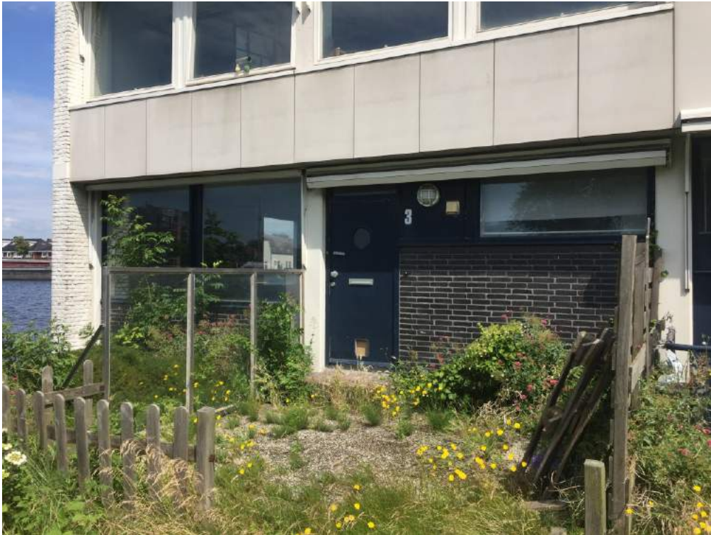
Voormalige conciërgewoning in iets terugliggende plint/souterrain, gemetselde gevelvlakken
