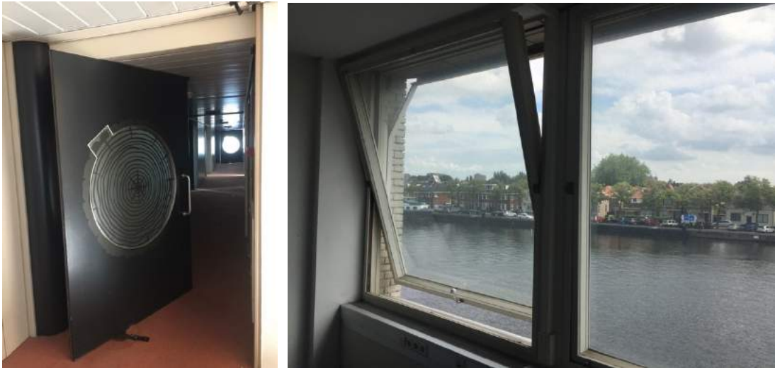
Taatsdeuren in de gangen, tuimelramen in de gevels
