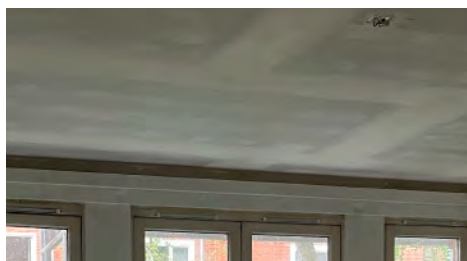
Nieuwe gipsplaten (naden dichtgesmeerd)
