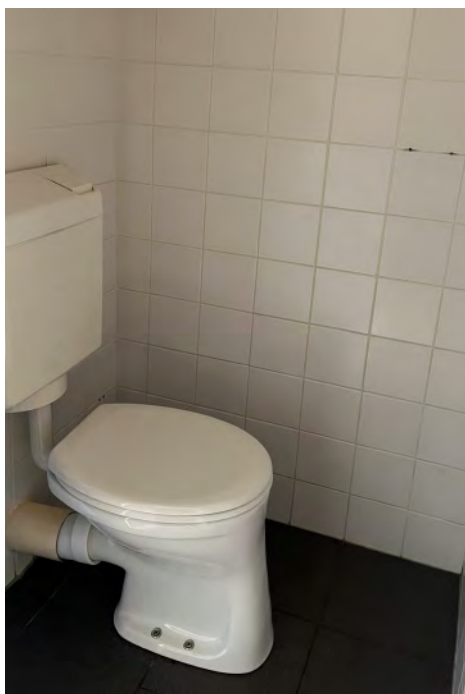
Toilet in goede staat
