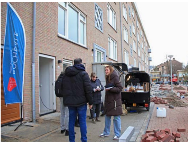
In totaal zijn 48 woningen gerenoveerd en 12 nieuwe studio's toegevoegd. Bij de renovatie is veel aandacht besteed aan comfort en duurzaamheid. Zo zijn de woningen klaar voor de toekomst.
